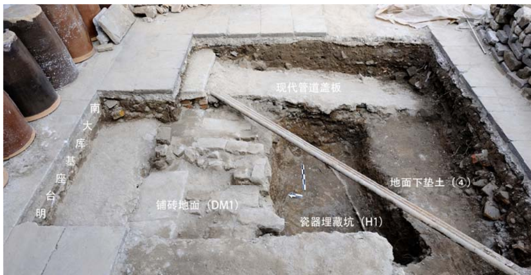
图 4、2014 故宫南大库发现的库房基座台明、室外铺砖地面与瓷器埋藏坑（西向东）
