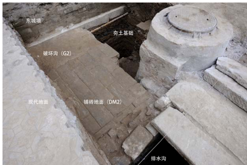
图 2、2014 故宫南三所外东南电力井发现的墙基、地面、排水沟与地面以下的夯土基础（西北向东南）
